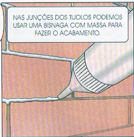
A MASSA PARA REJUNTAR PODE SER A USADA EM AZULEJOS, MASSA BRANCA MISTURADA A CORANTES OU SIMPLEMENTE UMA MISTURA DE SOLO-CIMENTO.
